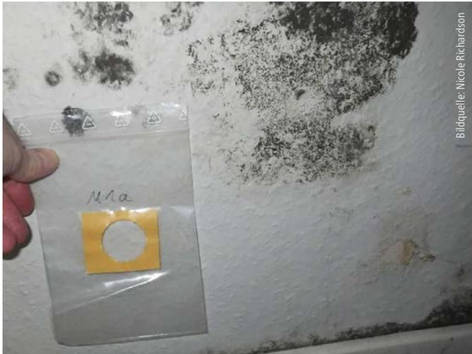
Abb. 7: Die Schimmelpilzbildung an der Wand führte zur Asbest-Probenahme bei Putz und Spachtelmasse.
