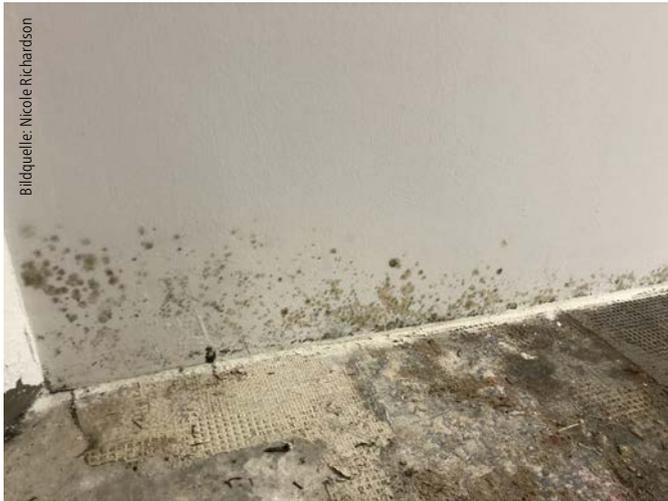
Abb. 3: Schimmelpilzbildung nach einem Wasserschaden
