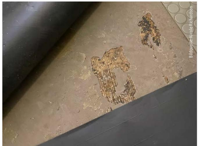
Abb. 6: Asbestfund im Bodenkleber
