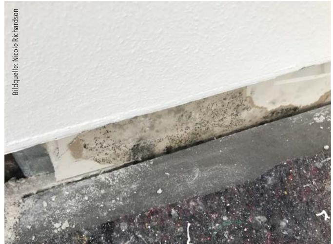
Abb. 4: Schimmelpilz hinter einer Fußleiste nach einem Wasserschaden
