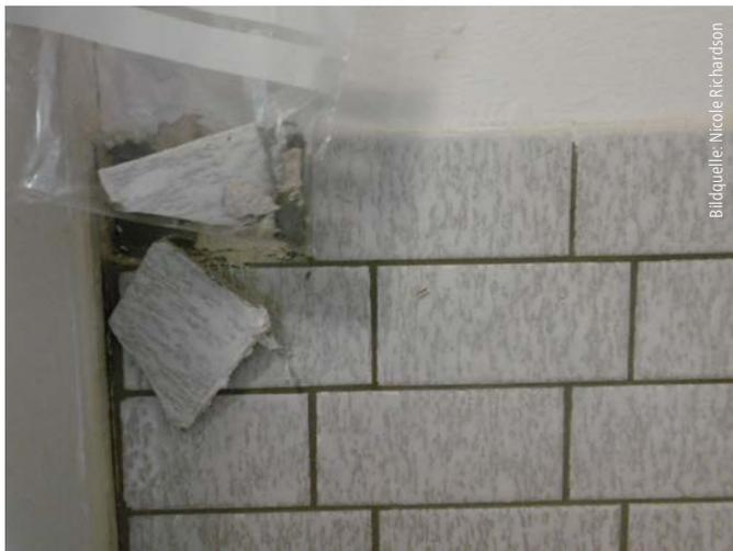
Abb. 5: Asbestfund im Fliesenkleber
