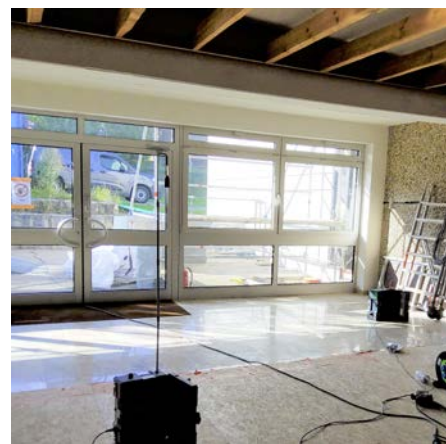
(5) Sanierungsbereich und Sanierungskontrolluntersuchung
